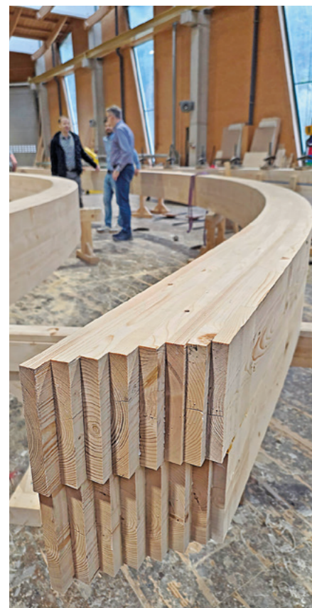
Große, komplexe Leimbinder für ebensolche Holzbauprojekte sind die Spezialität von Huter & Söhne
